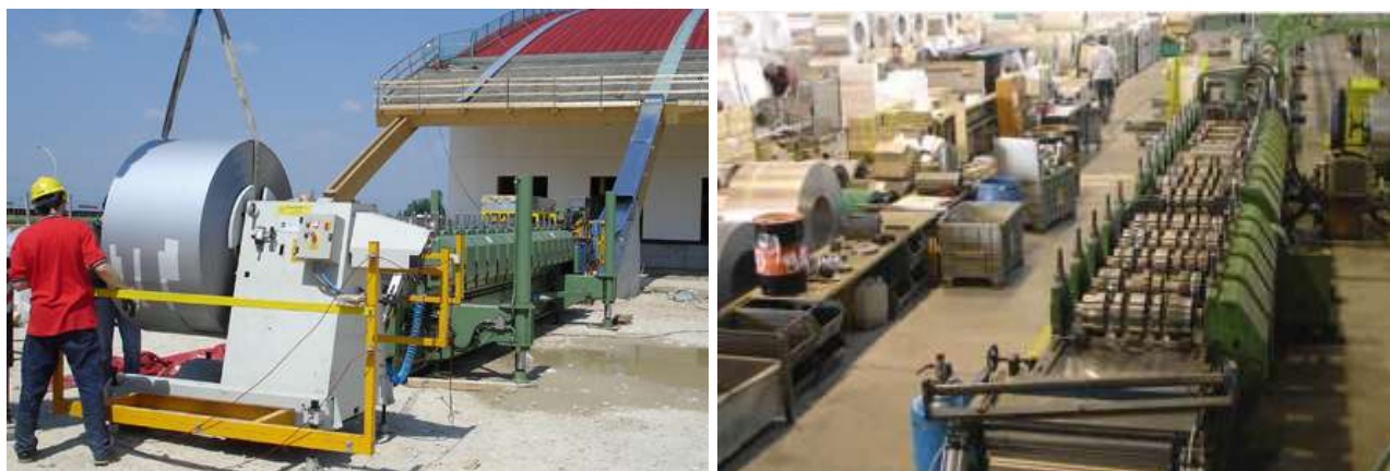
Produkcja paneli z wstęgi na placu budowy
